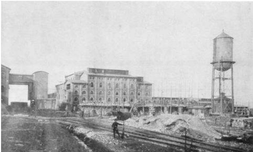
Blick auf die Verladestation und die im Bau befindliche Chlorkaliumfabrik
