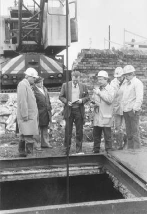
1985 Inspektion von Schacht 1 zur geplanten Verfüllung
