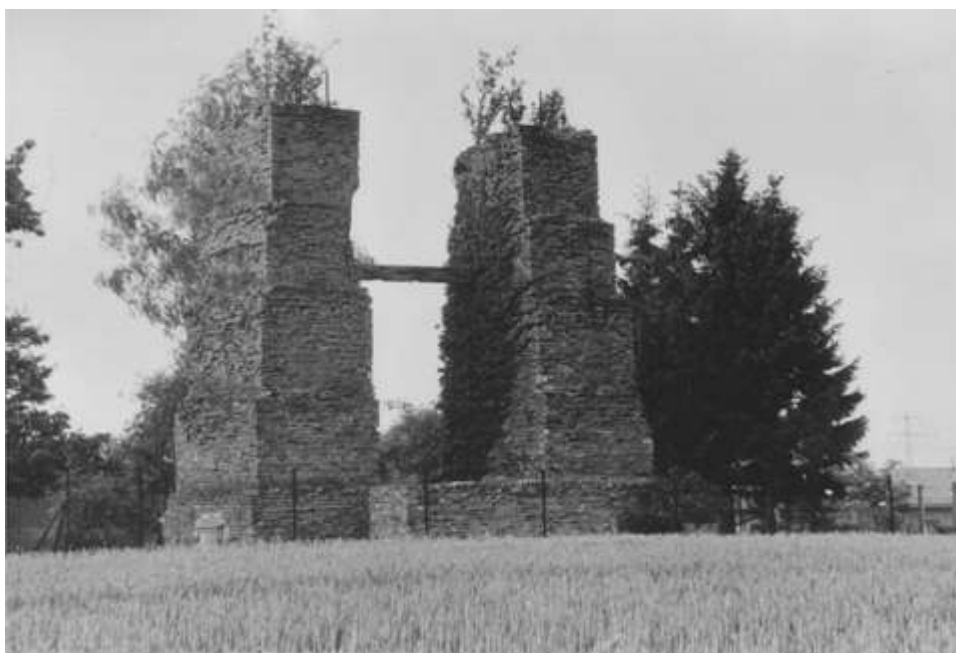
Gemauerter Förderturm von Schacht 2 „Elsbeth“
