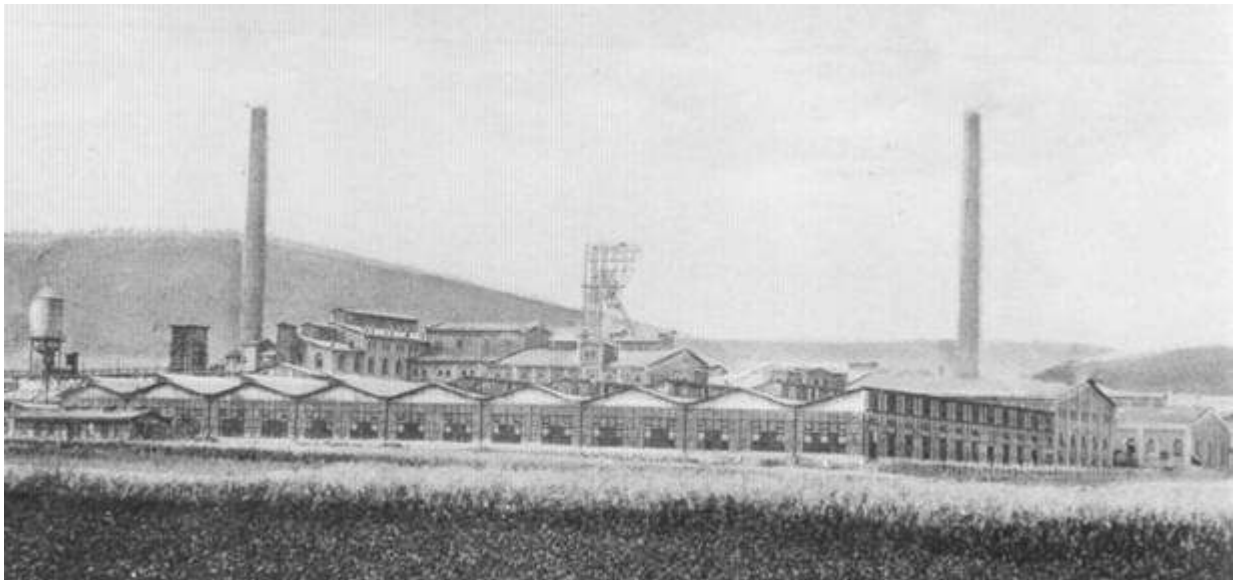
Das Kaliwerk von Osten gesehen
