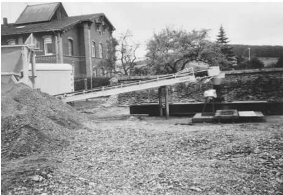
1990 Die Kiesverfüllung von Schacht 1
